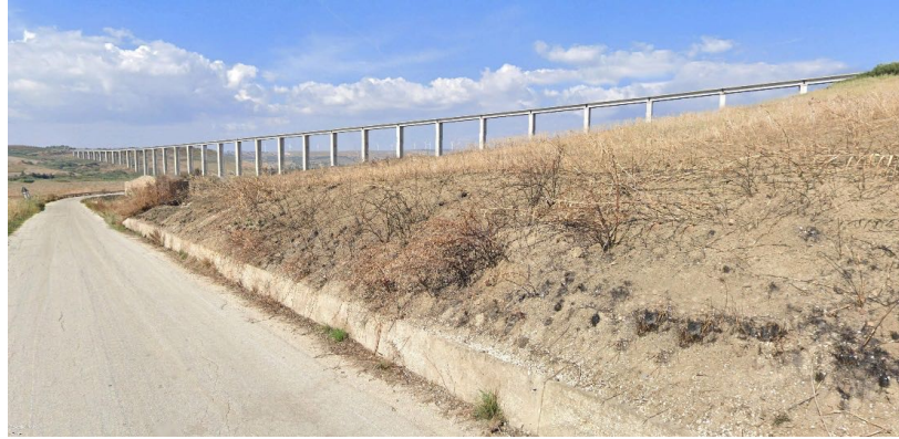
Figura 3 11 - Stato attuale Viadotto Carboj
